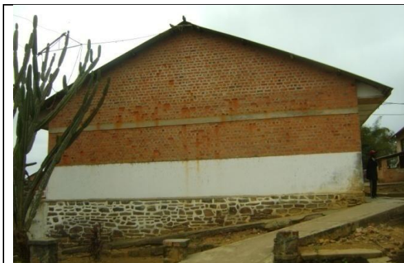
Vue de la rampe à l'entrée de la pédiatrie
