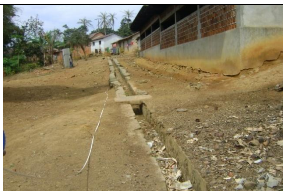
Caniveau derrière la cuisine
